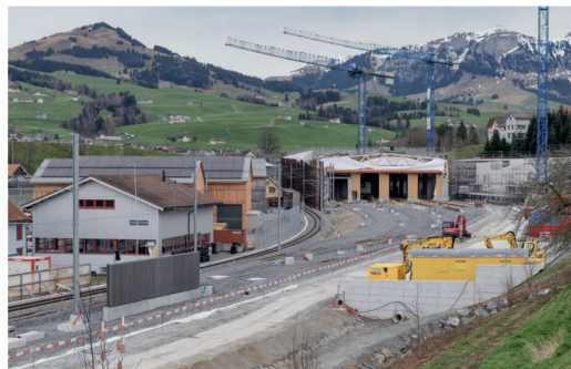
Das neue Servicezentrum entsteht. Die Anlage enthält vier Gleise: das Gleis ganz links für die Waschanlage und weitere drei für die Werkstatt.
