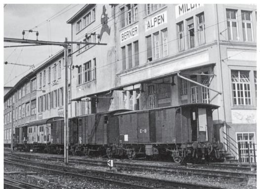
Der 1881 von der SCB-Werkstätte Olten an die EB ausgelieferte Gepäckwagen überlebte bis 1962 und erfuhr in seiner Dienstzeit einige Anpassungen. An der Rampe der BAMG wartet er auf einen weiteren Einsatz.
