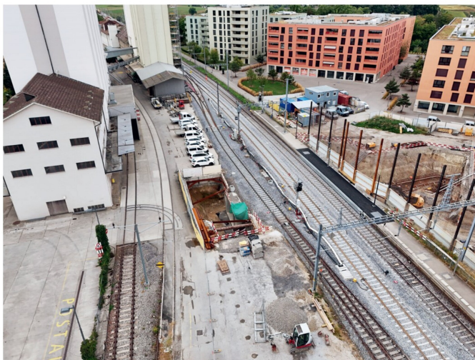
Die neue Strassenunterführung in Düdingen ist unter den Gleisen bereits fertiggestellt.
