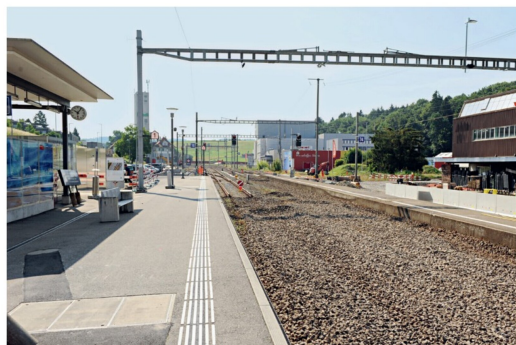
Drei Tage nach dem Baubeginn waren am 30. Juni 2025 im Bahnhof Schmitten ein Teil der Gleise und die Fahrleitung entfernt.
