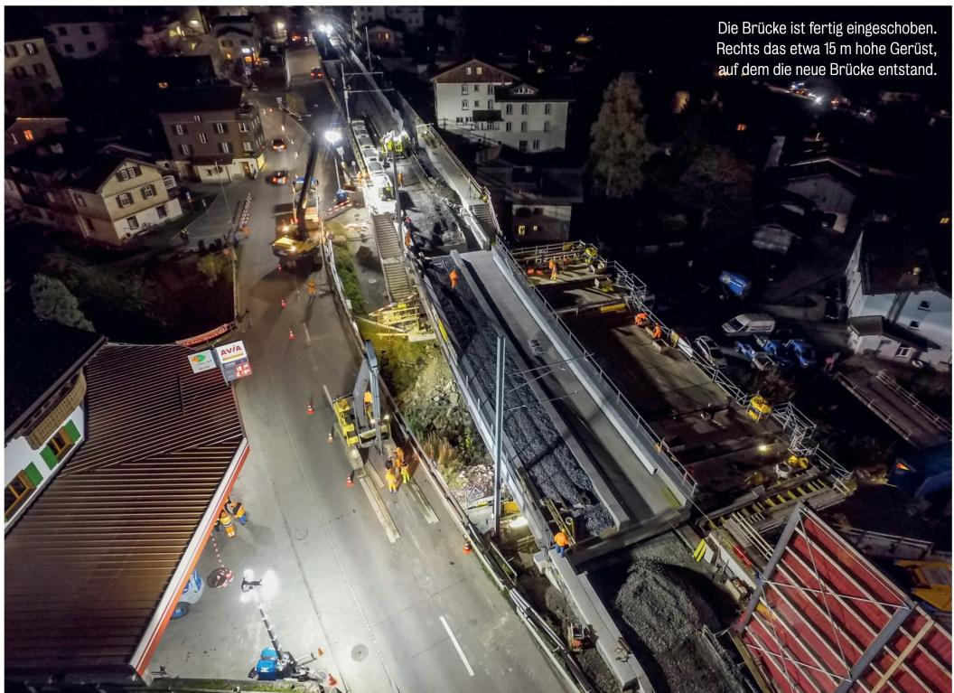
Die Brücke ist fertig eingeschoben. Rechts das etwa 15 m hohe Gerüst, auf dem die neue Brücke entstand.
