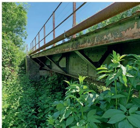
Die Brückenstreben zeigen leichte Korrosionsspuren, insbesondere an den Nieten. Dies vermischt sich mit grünlichen Tönen von Moos und Feuchtigkeit.
