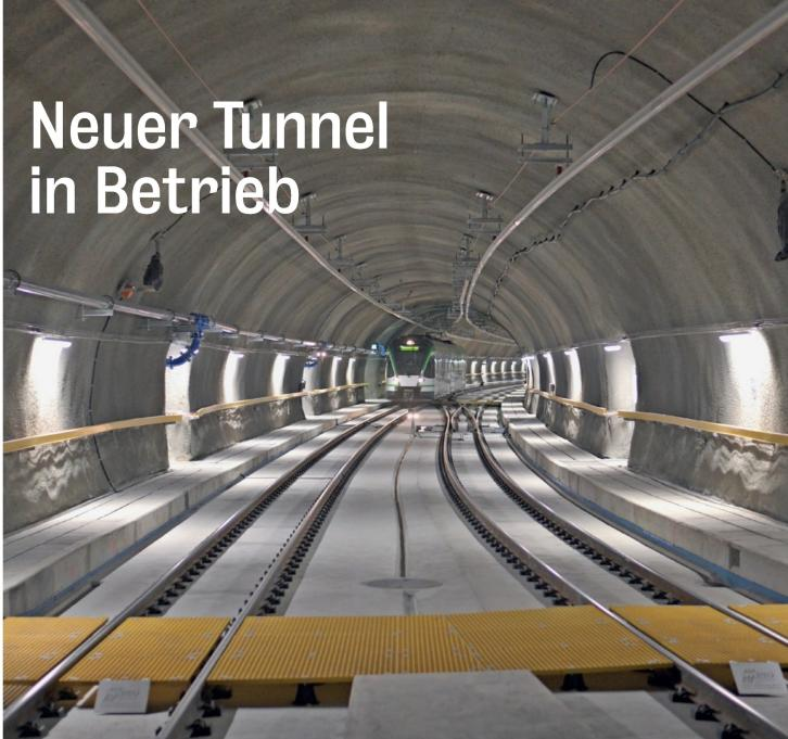
Moderne Bahninfrastruktur auf schmaler Spur mit einer festen Fahrbahn und Oberleitungsschiene. Die Aufnahme zeigt den Blick von der Haltestelle Chauderon aus in die Richtung des neuen Tunnels.
