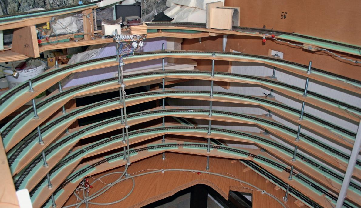
**Bau | Der Bau einer Gleiswendel aus trapezförmigen Segmenten**
