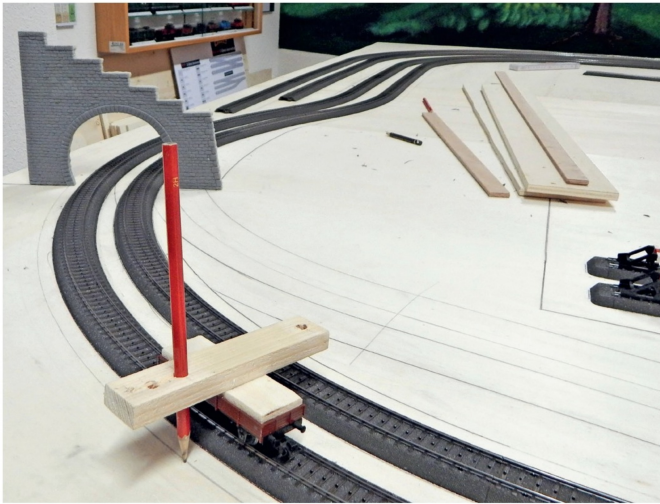
Mit einem präparierten Flachwagen wird die Gleisführung eingezeichnet.
