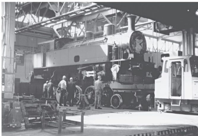
Aufsetzen der Lok auf das eingeachste Fahrgeäst im Ausbesserungswerk Meiningen.
