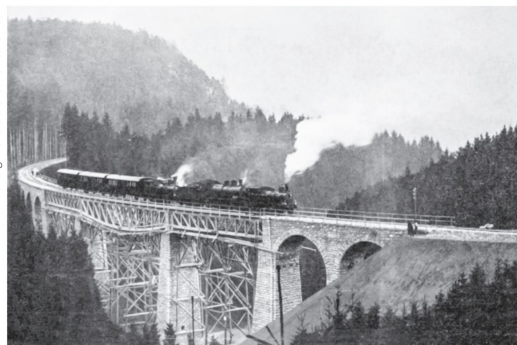
Die Belastungsprobe des Geisslochviaduktes erfolgte mittels zweier Ed 3/4 der SMB und einer Schleptenderdampflok C 4/5 der SBB.
