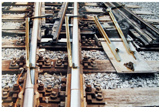
Fertige Zungengarnitur und oberes Verschlussstück auf dem Foto drapiert.
