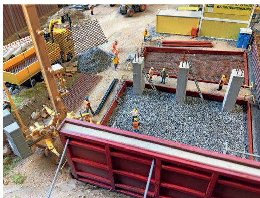
Die Verschalung der Betonwand wurde nach hinten abgestützt.
