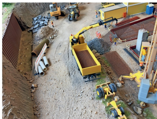
Mit dem Autokran werden die Stahlmatten auf der Baustelle abgeladen.
