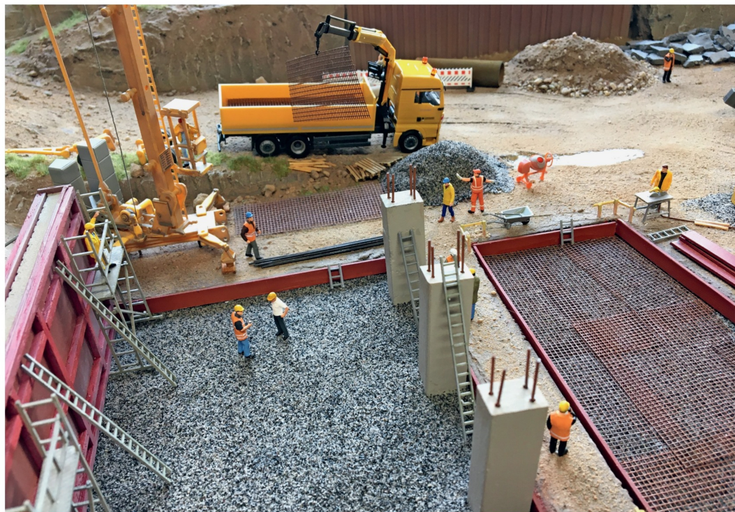
Die Bauarbeiten beginnen mit der Verlegung der Baustahlmatten auf der Bodenplatte, bevor der Beton eingegossen werden kann.
