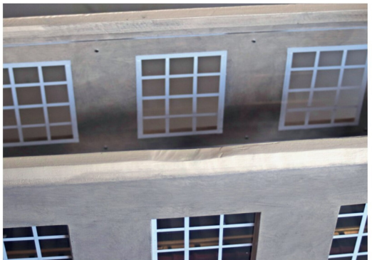
Die Fensterplatten werden mittels Schrauben am Gebäude befestigt.
