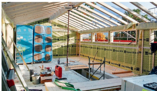
Das Dachgeschoss wurde in Fertigteiltbauweise errichtet.
