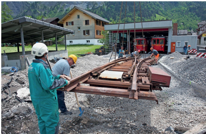
Vereinsmitglieder beim Einbau der ersten Weiche vor dem Depot der Sernftalbahn in Elm.
