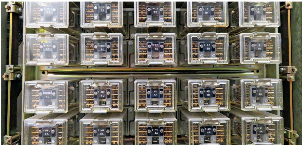
Jedes Fahrwegelement wie eine Weiche oder ein Gleisabschnitt wird durch eine eigene Relaisgruppe gesteuert.
