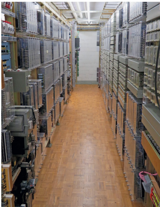
Der Relaisraum ist das Herzstück der EBL-Anlage. Auch bei der grossen Eisenbahn stehen heute noch zahlreiche Relaisstellwerke im Einsatz.
