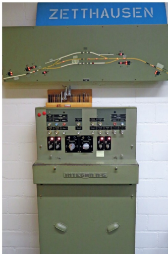
Zetthausen wird über ein elektromechanisches Schalterstellwerk bedient. Auf der Anzeigetafel ist die Belegung durch den ICN zu sehen.
