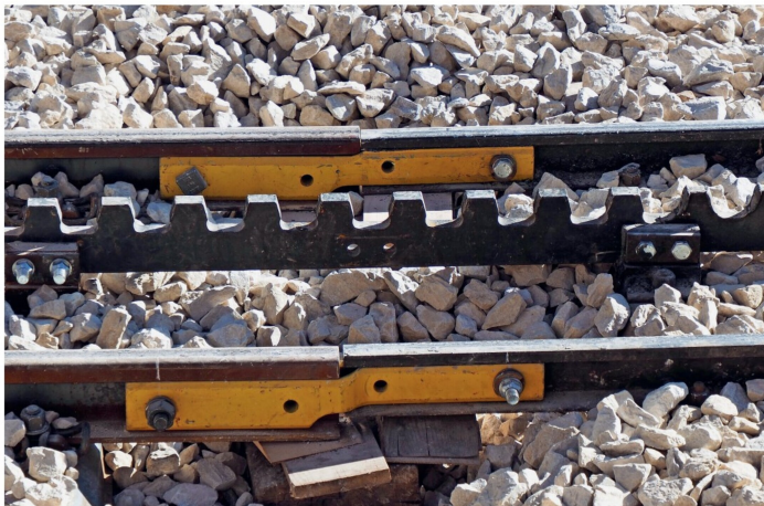
Deutlicher Unterschied zwischen neuem und altem Gleismaterial beziehungsweise bei der Zahnstange, bei der sich der Übergang ganz rechts befindet. Bei geringer Neigung ist nur eine Lamelle verlegt.
