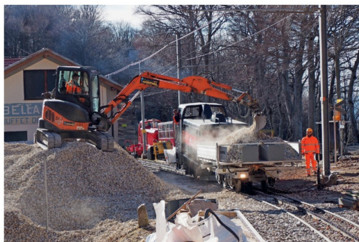
Schotterverlad auf den dafür umgebauten Kipper M 6.
