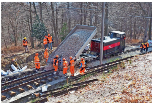
Einschottern des bereits ausgewechselten Gleises.
