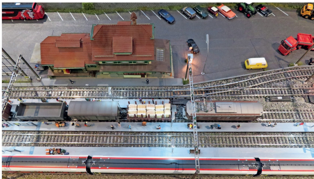
Der ICN auf Gleis 4 und ein Güterzug der Bern-Neuenburg-Bahn auf Gleis 2 warten auf ihre Ausfahrt. In der Abenddämmerung leeren sich die Gleise.
