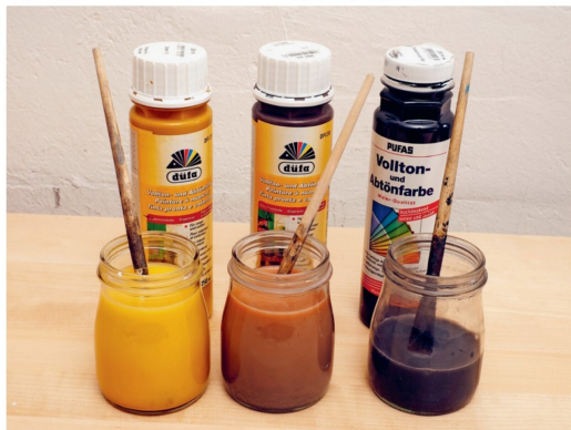
Die drei Farben Ocker, Braun und Schwarz werden stark verdünnt und gleichzeitig vorbereitet, weil die Lasur «nass in nass» aufgetragen wird.
