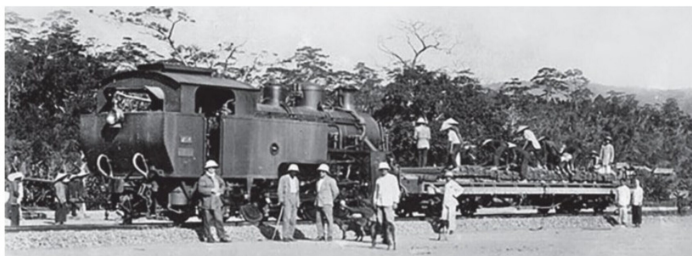
Ab 1923 wurden bereits die neuen Lokomotiven HG 4/4 beim Bau der Bergstrecke eingesetzt.
