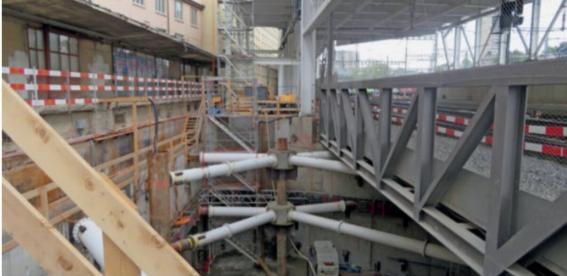
Vom Zugangsschacht an der Laupenstrasse aus werden die Kavernen für den neuen unterirdischen RBS-Bahnhof unter den Gleisen der SBB ausgebrochen.
