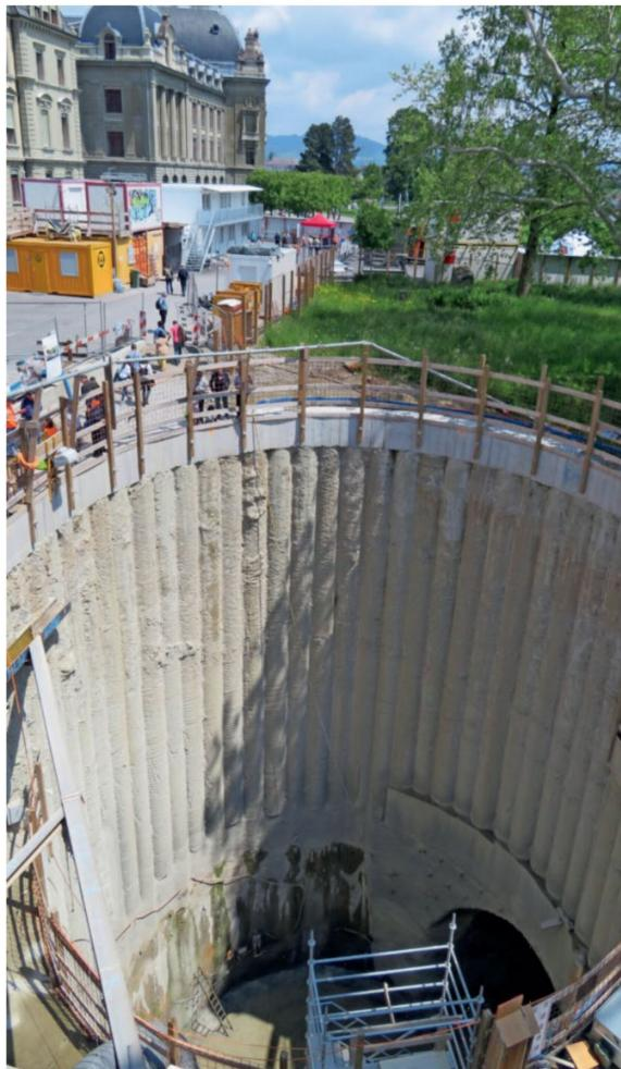
Auf der Grossen Schanze beeindruckte der 30 Meter tiefe Schacht für den Bahnhofzugang von der Länggasse aus zur künftigen Unterführung Mitte.
