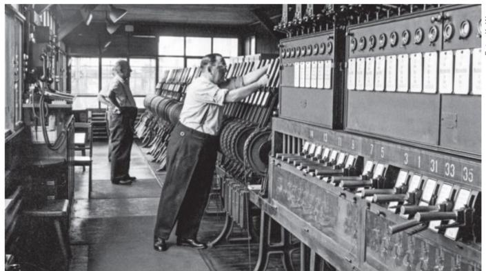
1927 von Signum Wallisellen geliefert: das Stellwerk der Bauart Bruchsal J im Stellwerk II in Basel SBB PB.
