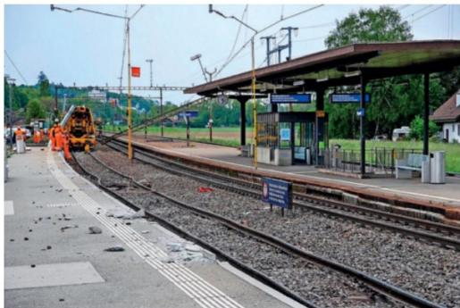
Neben der Perronkante wurde die Gleis- und Fahrleitungsanlage beschädigt.
