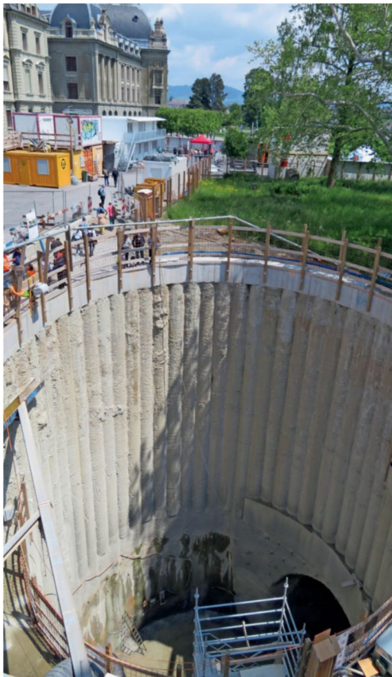
Auf der Grosse Schanze beeindruckte der 30 Meter tiefe Schacht für den Bahnhofszugang von der Länggasse aus zur künftigen Unterführung Mitte.
