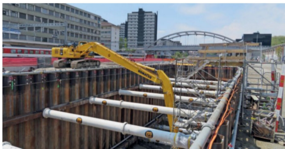
Auf der Grosse Schanze beeindruckte der 30 Meter tiefe Schacht für den Bahnhofszugang von der Länggasse aus zur künftigen Unterführung Mitte.
