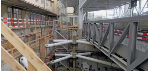
Vom Zugangsschacht an der Laupenstrasse aus werden die Kavernen für den neuen unterirdischen RBS-Bahnhof unter den Gleisen der SBB ausgebrochen.
