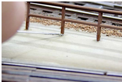
Alle Kunststoffpfosten mit dem flüssigen Sekundenkleber fixieren.
