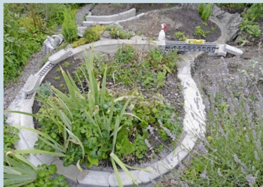
Als Fundament habe ich kleine Betonelemente wie Rasenkantensteine oder Gehwegplatten benutzt. Es erwies sich als notwendig, diese Steine nicht nur auf ein Splittbett zu verlegen, sondern mit Armierung darauf festzumauern.
