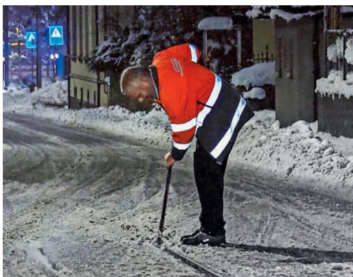
Es gibt Arbeiten, die bleiben über Jahrhunderte gleich. Wie hier das Ausschaben der Schienen im Strassenbereich am 13. Januar 2019 in Chur.
