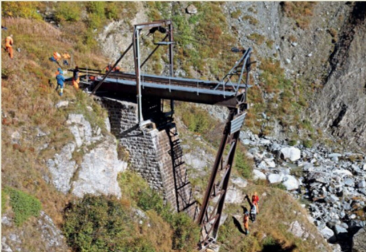
Der bergseitige Teil der Brücke wird zurückverscho
