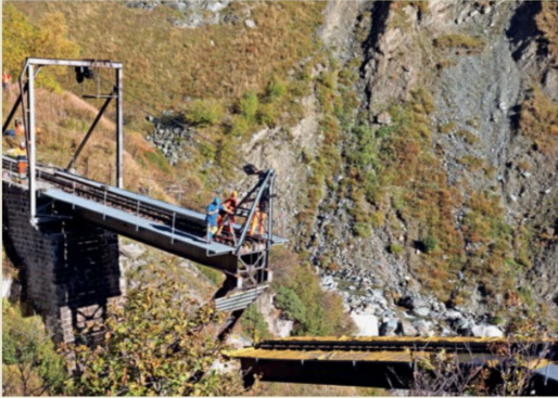
Der erste, talseitige Brückenteil wird nun heruntergelassen.
