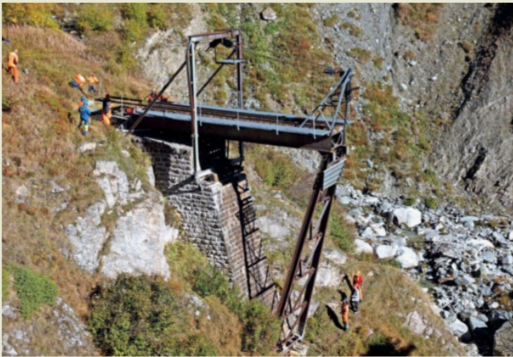
Der bergseitige Teil der Brücke wird zurückversoben (Lawinensicherheit).
