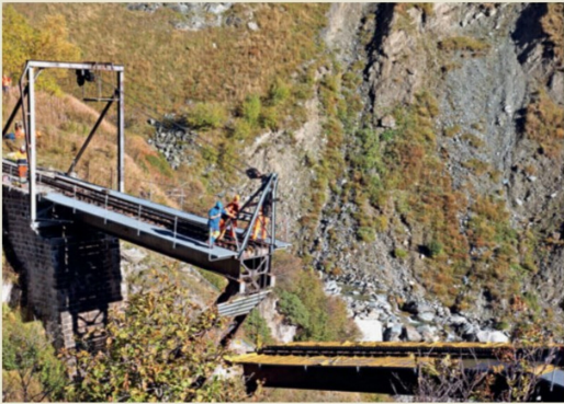
Der erste, talseitige Brückenteil wird nun heruntergelassen.
