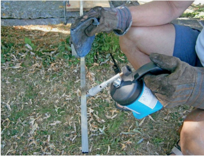
Durch das Verzinken des Rohrs mit dem Schweißbrenner wird die Schiene silbern.
