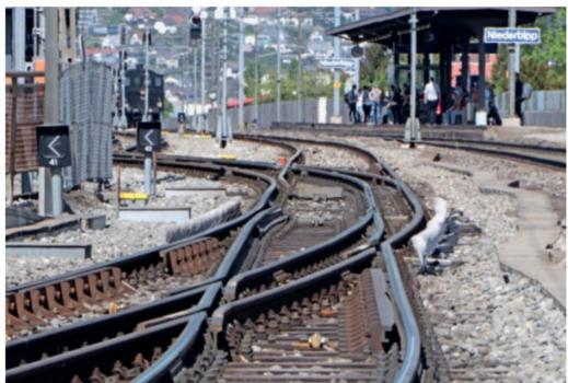
Dass die Vorbildeisenbahn ihre Gleise nicht aus dem Zubehörkatalog eines Modellanbieters beziehen kann, zeigt diese spezielle Weichenkonstruktion in Niederbipp beim Übergang zwischen der SBB und der ASm.
