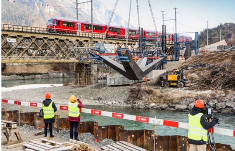
Die neue Stütze 3 schwebt über dem Hinterrhein, um auf dem vorbereiteten Fundament Seite Bahnhof Reichenau die endgültige Position einzunehmen. Im Hintergrund die Brücke aus dem Jahr 1895.
