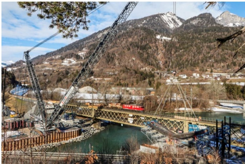
Der schwach ausgelastete Zug 5120 mit der Lok 701 passiert die Baustelle (o.), wo auf dem weit ins Flussbett ragenden Installationsplatz der riesige Raupenkran die schweren Brückenteile positioniert (u.).
