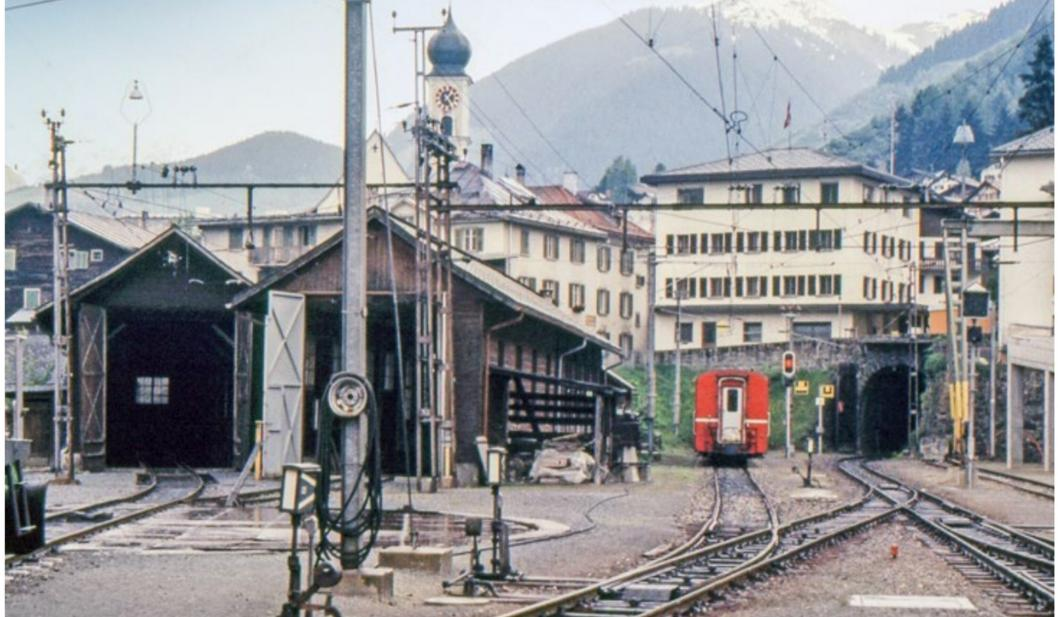
**Detailansicht der Station Disentis/Muster mit Blickrichtung Oberalppass.** Die FO unterquert nach der Tunneleinfahrt etwa in einem 90°-Bogen den Ort. Das steil ansteigende Gleis ist mit einer Zahnstange ausgerüstet. Der rechte Lokschuppen ist für RhB-Triebfahrzeuge, der linke für FO-Lokomotiven. Davor die handbetriebene Drehscheibe.
