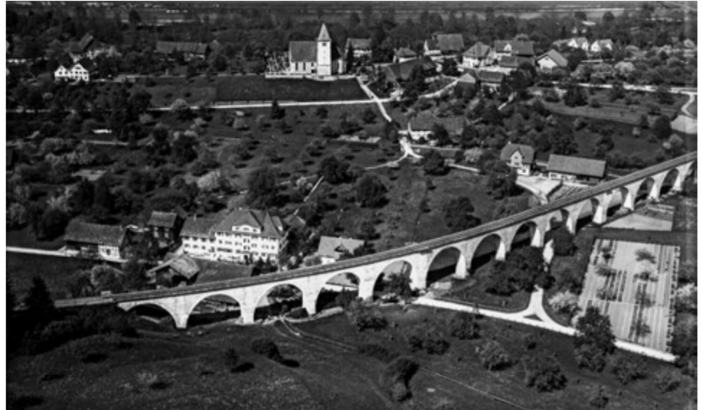
Elegantes Bussnanger Viadukt mit 15 Bogenöffnungen zu 16,5 m. Länge ca. 277 m. Bauzeit nur 6 Monate.
