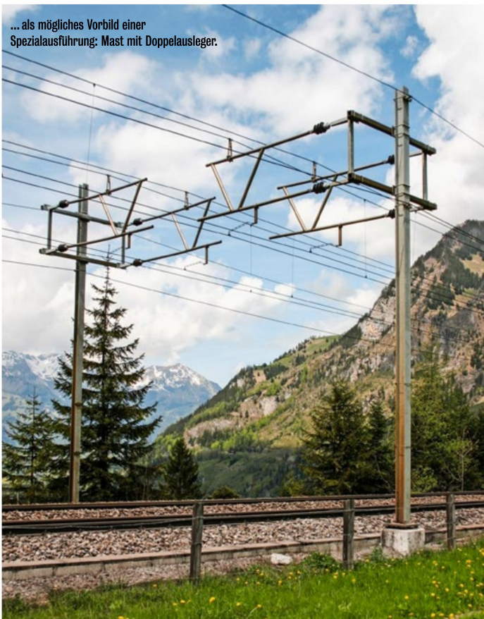
Das Vorbild der Fahrleitungsmasten in der sogenannten «Normalausführung» und ...
