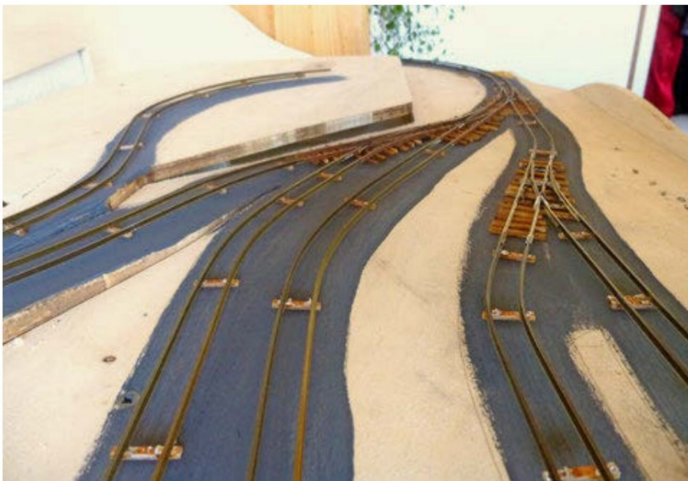
Im Bereich der Gleislage habe ich vor dem Einbau der Gleisjoche die Holzplatte grundiert.
