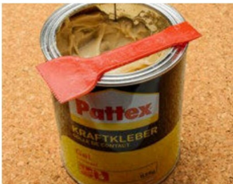
Die zugeschnittenen Korkplatten wurden mit Pattex-Kraftkleber beidseitig bestrichen.
