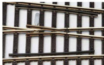
Vor der Verarbeitung einer Elite-Weiche werden die Herzstückteile mit Kleber gesichert.
