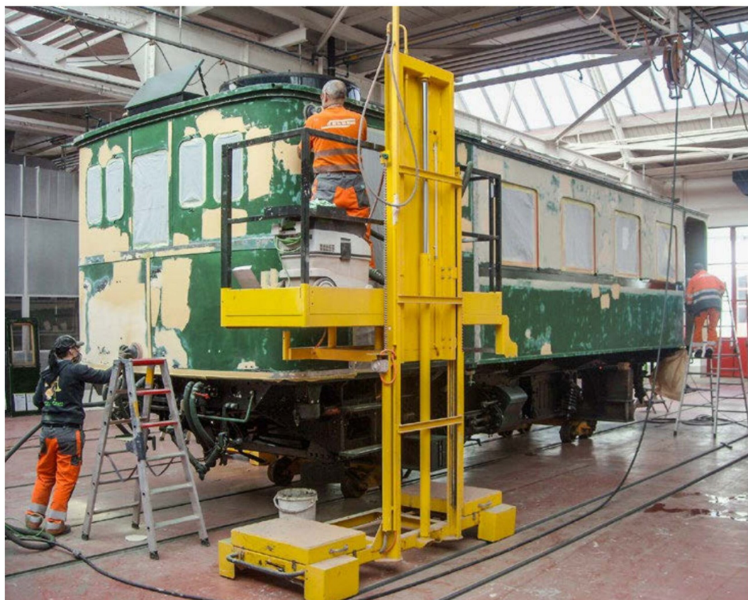
Nach stellenweisen Schlosserarbeiten am Wagenkasten musste die gesamte Aussenhaut gründlich ausgespachtelt und abgeschliffen werden.
