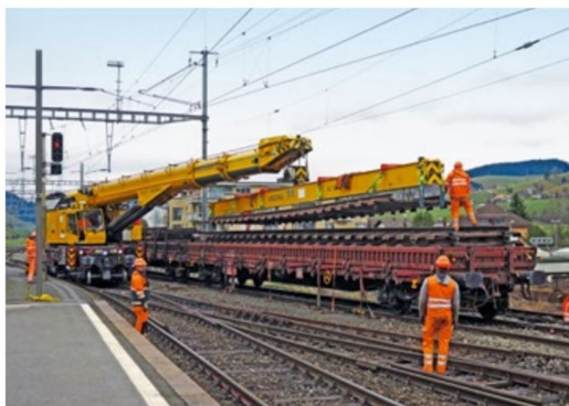
Am 9. März 2017 erfolgte der Rückbau von Teilen der Gleisanlage. Für das Heben der Weichen- und Schienenteile wurde ein Vanomag-Kran eingesetzt, während der Abtransport durch AAE-Res und Euroswitch-Wagen erfolgte.
