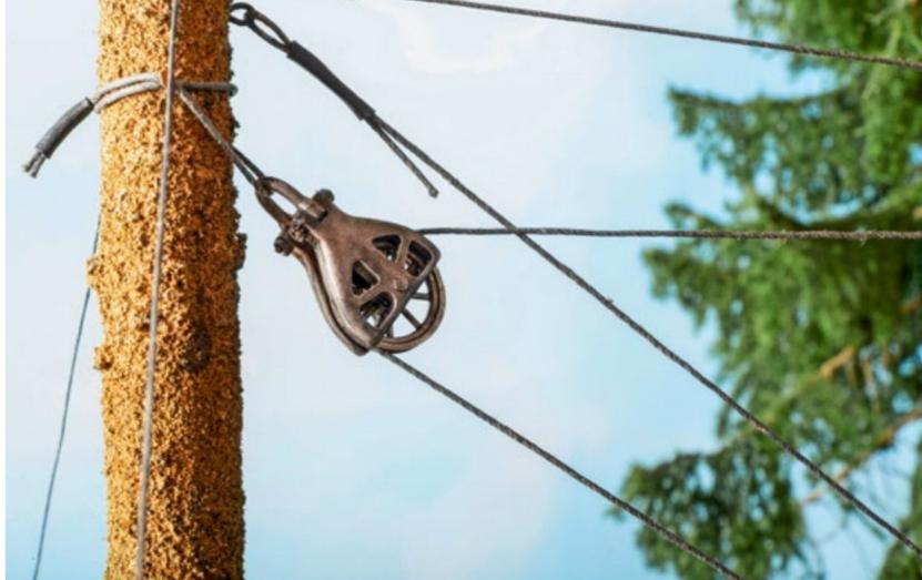
Auf beiden Seiten der Gleise werden die Umlenkrollen an den Baumstämmen befestigt und die benötigten Seile eingezogen.
