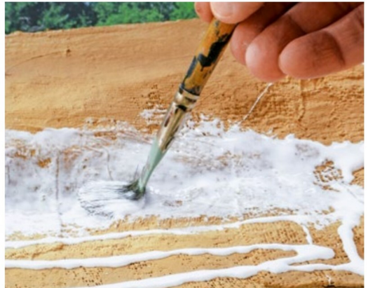
Auf den vorbereiteten Untergrund wird Weissleim aufgetragen, auf den ...
