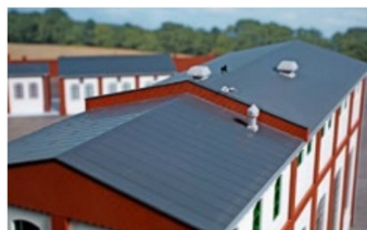
Brandwände müssen über Dach geführt werden.
