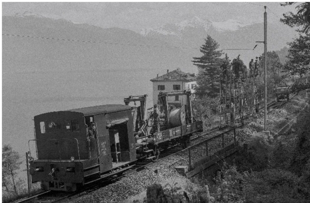
Ein Traktor Tm 2/2 des Bahndienstes im April 1960 im Einsatz bei der Elektrifizierung der Bahnlinie nach Luino bei Ranzo am Lago Maggiore.
