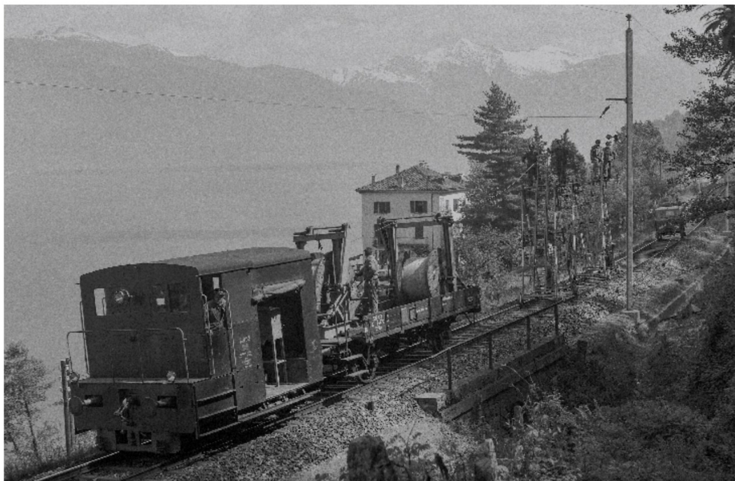
Ein Traktor Tm 2/2 des Bahndienstes im April 1960 im Einsatz bei der Elektrifikation der Bahnlinie nach Luino bei Ranzo am Lago Maggiore.
