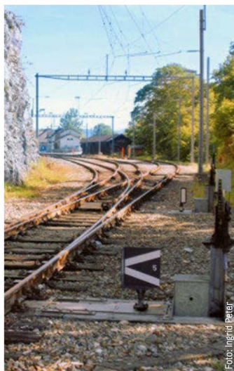
Die asymmetrische Dreiwegweiche ist durch normale Linksweichen zu ersetzen.
