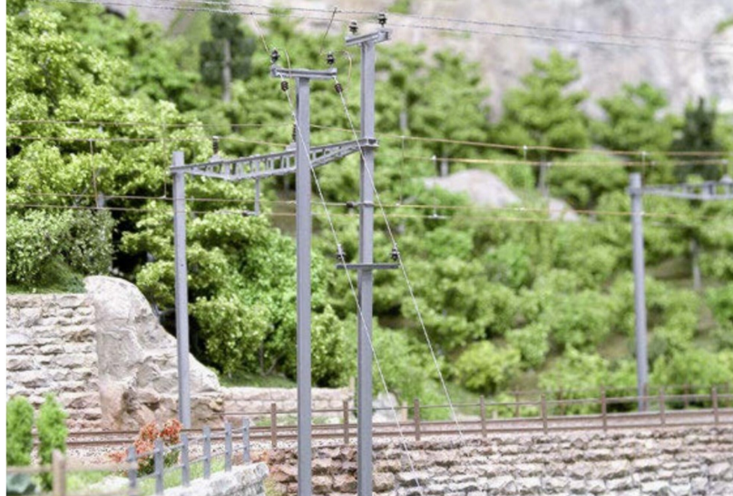
Die Stromeinspeisung in die Fahrleitung wird mit einem separaten Mast realisiert.
