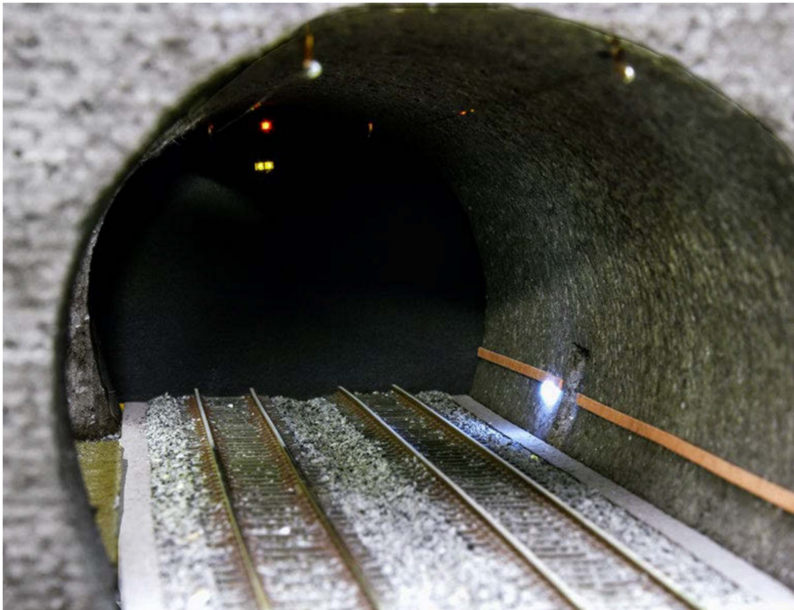
Blick in eine ausgebaute Tunnelröhre mit Notbeleuchtung, Nische, Handläufen und Tunnelsignal.
