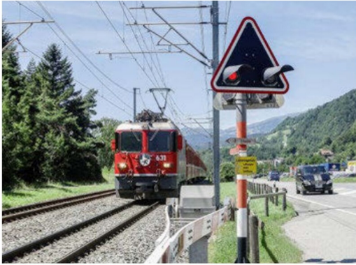
Zwischen den RhB-Stationen Domat-Ems und Reichenau-Tamins befindet sich dieser mit Bahnschranken und Wechselblinkern ausgestattete Übergang. Auf den beiden Fotos ist das wechselnde Blinklicht und die Konstruktion der Schrankenbäume gut ersichtlich.
