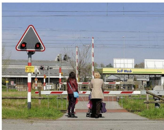
Im Grenzbahnhof St. Margrethen befindet sich an der Einfahrtseite Rohrschach ein mit Wechselblinken und Bahnschranken ausgestatteter Bahnübergang für Kraftfahrzeuge, auf der Seite Richtung Chur respective Bregenz (A) hat es streckenabhängig zwei Übergänge für Fußgänger.
